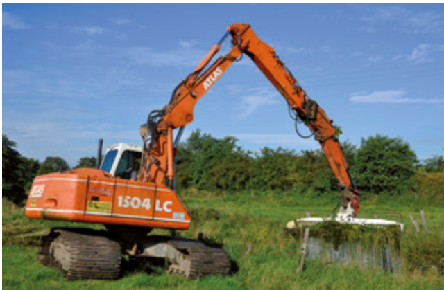
Abb. 6: Gewässerunterhaltung ist auch bei breiten Gewässerrandstreifen möglich, diese Fälle sind bereits in den Satzungen der Wasser- und Bodenverbände geregelt.
