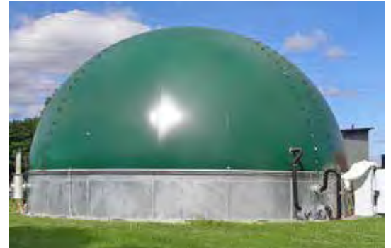
Mit einem Versuchsbehälter haben Wissenschaftler des KIT die Auswirkungen verschiedener Umgebungsbedingungen auf textile Membranspeichersysteme untersucht. Foto: kit
