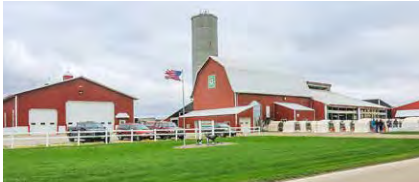
Auf der Farm findet man alte und neue Gebäude nebeneinander.
