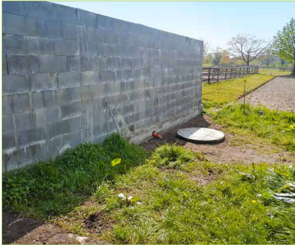
Bild 6: Festmistlager mit Ableitung in einen Sammelbehälter
