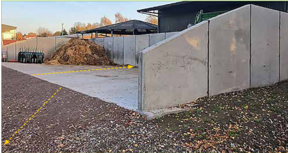
Bild 4: Festmistlager mit Gefälleausbildung und flüssigkeitsundurchlässigen Seitenwänden
