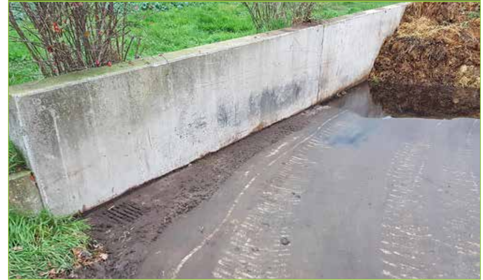
Bild 5: Festmistlager mit funktionstüchtigem Einlauf zum Sammelbehälter
