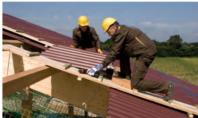
*Vorbildliche Arbeitsweise: Es werden Laubohlen verwendet und unter der Dachhaut sowie an den Absturzkanten sind Auffangnetze gespannt. Bohlen und Netze sind ebenso bei Reparaturarbeiten auf alten Dächern zu verwenden.*
