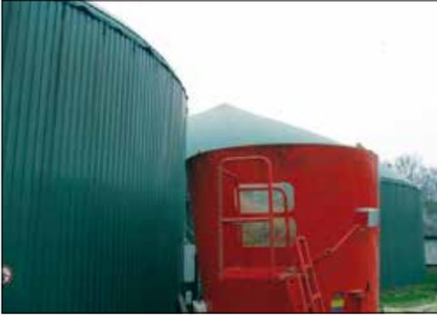
*Feststoffdosierer mit Aufstieg zur Kontrolle oder Entstörung sowie Schaugläsern*
